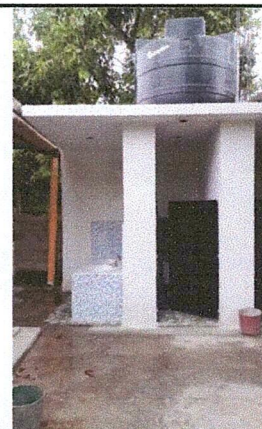
Foto 4: MEJORAMIENTO DE SANITARIO
