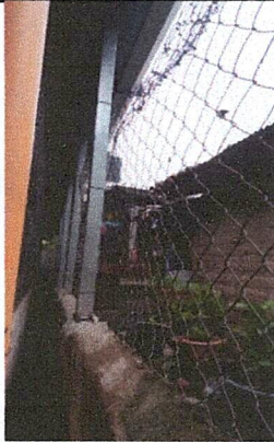
Foto 5: MEJORAMIENTO MURO PERIMETRAL
