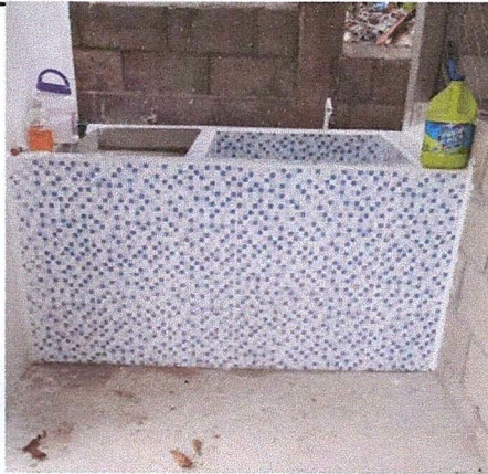
Foto 3: MEJORAMIENTO DE PILA
